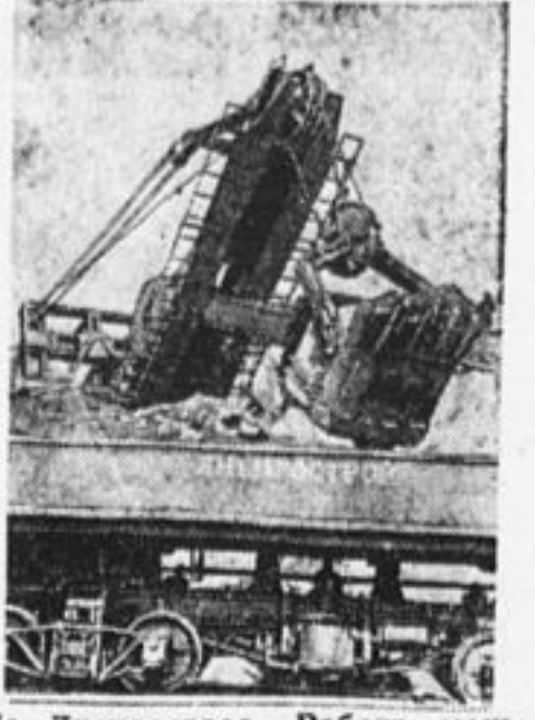
На Днепрострое. Работа мощного экскаватора.
